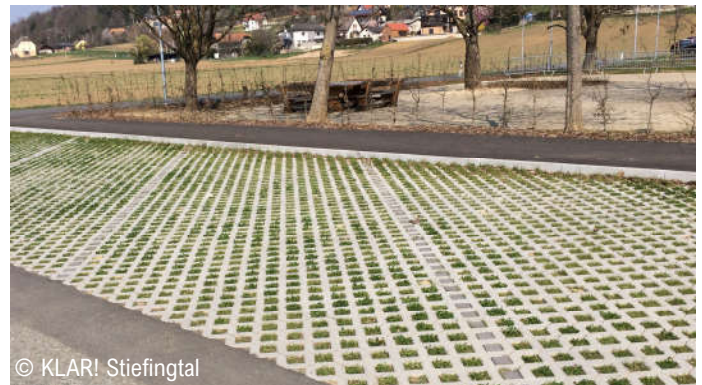
Rasengittersteine als Beitrag zur Klimawandelanpassung
